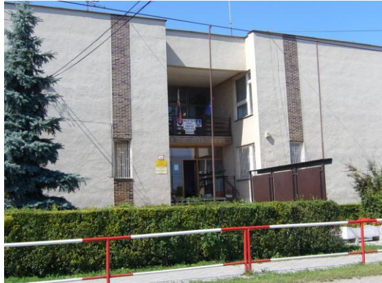
Foto 2: Občianska infraštruktúra obce – budova železničnej stanice
